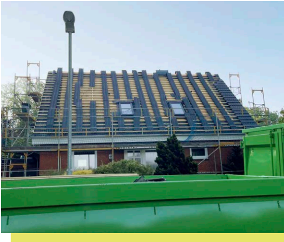
Das Dach kommt neu
