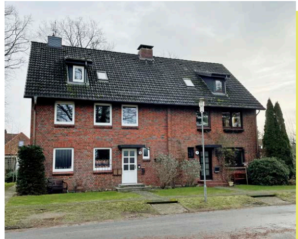
Ungedämmt und mit altem Dach sah es früher so aus
