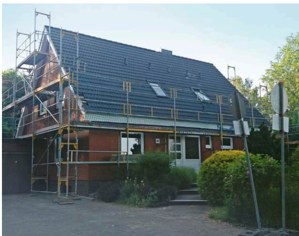
Eingerüstet und sanierungsbereit
